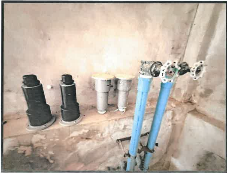
รูปภาพติดตั้ง Ejector pump
